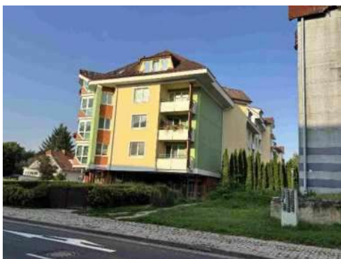
Bytový dom, pohľad bočný a zadný z ulice M.R.Štefánika
