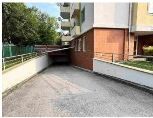
Bytový dom, rampa do podzemného parkoviska
