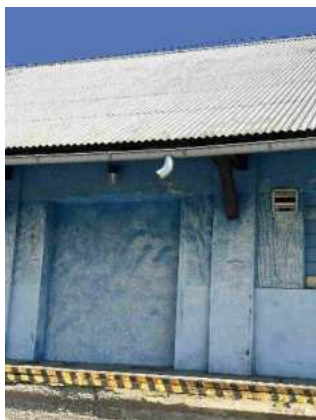
Strecha a klampiarske práce
