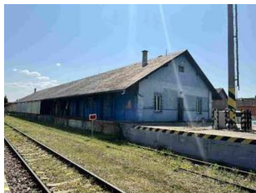
Sklad, pohľad od trate
