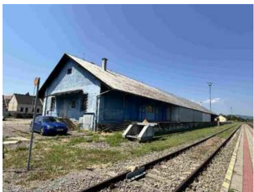
Sklad, pohľad od trate
