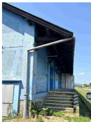
Rampa od trate
