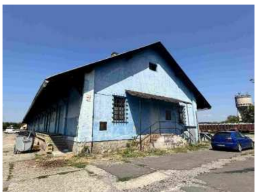
Sklad, pohľad od čelný od železničnej stanice
