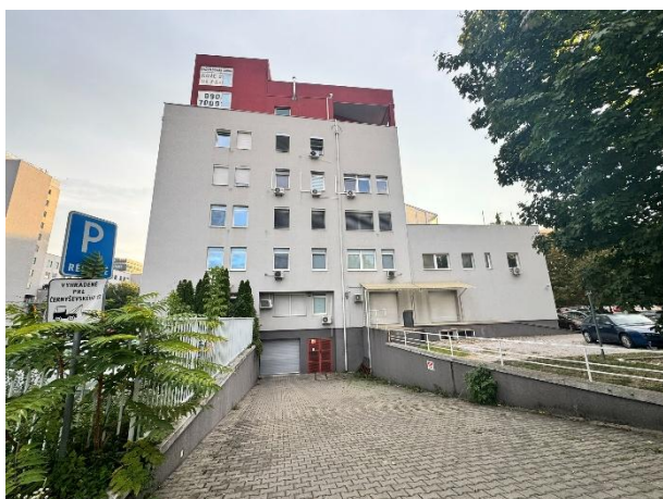
Zadná strana bytového domu s vjazdom do garáže
