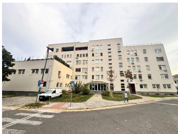
Pohľad na bytový dom – vstupná strana
